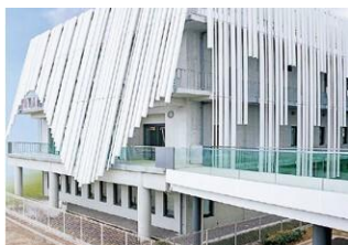
神戸大学統合研究拠点 (バイオものづくり研究棟)
