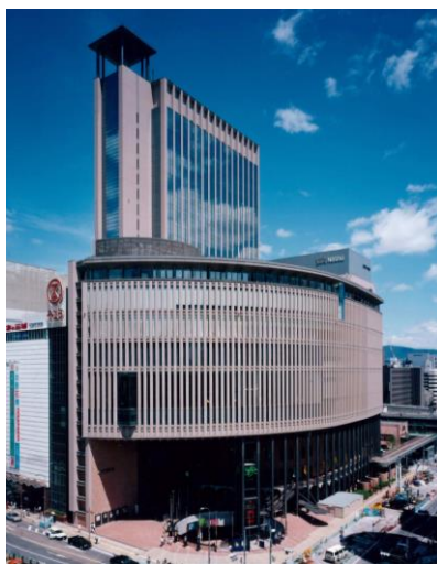
9 リージャス神戸国際会館ビジネスセンター
